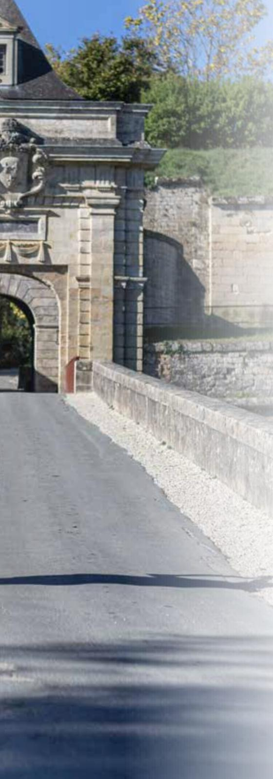
Les ouvrages comportent des maçonneries de grande qualité dressées en petit dont les calibres sont rigoureusement identiques. Les chaînages de grand appareil rythment l'élévation des parements. Implantés en moyenne tous les 7,3 mètres, ils correspondent toujours aux contreforts intérieurs enterrés dans le rempart.
